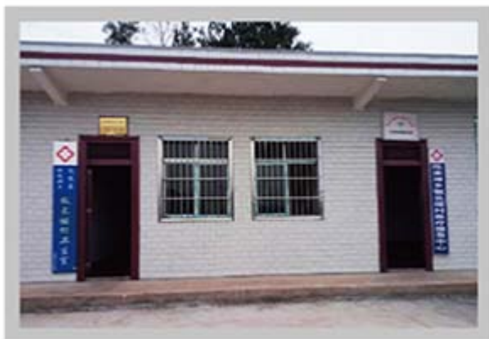
沅陵县冷水井镇刘家坝村卫生室已装修完成。
