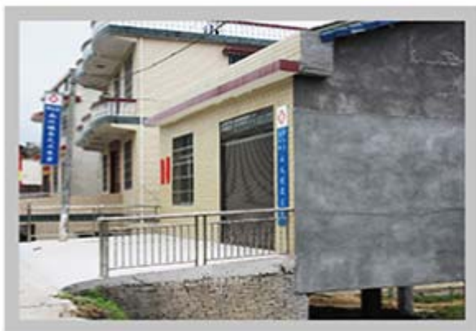
平江县南江镇永强村卫生室主体已完工，正在装修。
