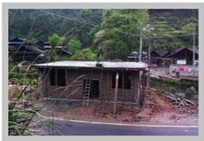
通道县江口乡大团村卫生室主体建设基本完工，正在进行室内和外墙的粉刷中。
